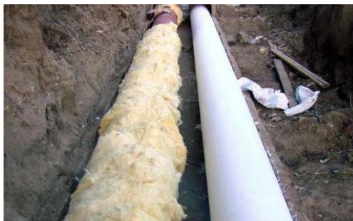
Рисунок 4 – Изоляция на трубопроводе
